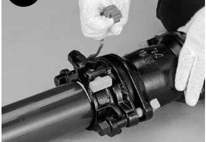
分解せずに継手を標線まで入れ、仮止めスペーサを取り外します。
