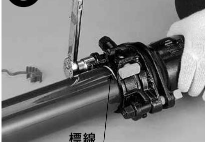
ストップリングは押輪と接した状態で標線と合わせます。
