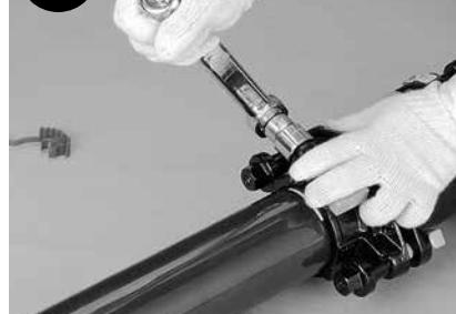
ストップリングを標線に合わせた状態で、ストップリング上部を押さえながら、ストップリング締付ナットを締め付けて下さい。
